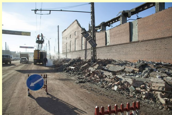
Једна од последица експлозије метеора - урушен кров на фабрици цинка у Чељабинску.
